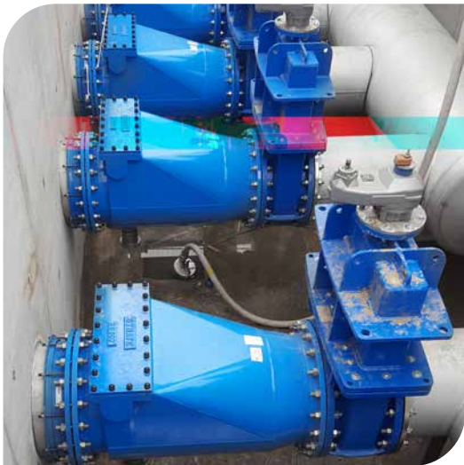
TRAITEMENT EAUX USÉES ARCAÇON - FRANCE Adaptateurs à brides Clapet RSK/ FTUD
