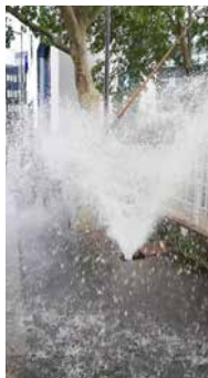
Bouche d'incendie RESTREETO® ouverte en position "débit réduit"
