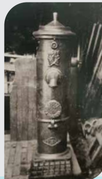
Équipée d'une "boite à trop-plein" servant de brise-charge et supprimant le presse-étoupe et donc les frottements.
